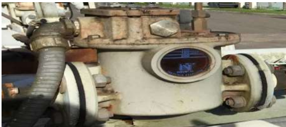
Figura 11 - Relé de Gás. Fonte: (Imagem retirada de um transformador usado).
