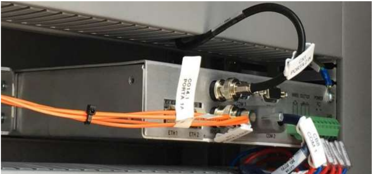
Figura 31 – GPS sincronismo da rede de automação da SAS. Fonte: PN-002
