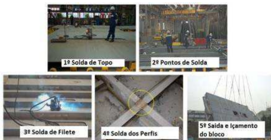
Figura 3.31 estágio da construção do bloco da casa naval (Adaptado SHIN,2011).
