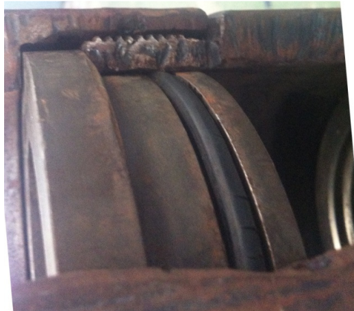
Figura 17: Corte real do contato de vedação entre a camisa vs. anel selante (região de recuperação da ombreira).
