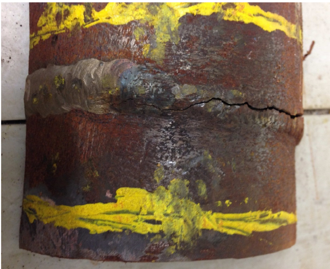
Figura 2 - Seção do Half-pipe Jackets trincado na junta de topo – parte externa.
