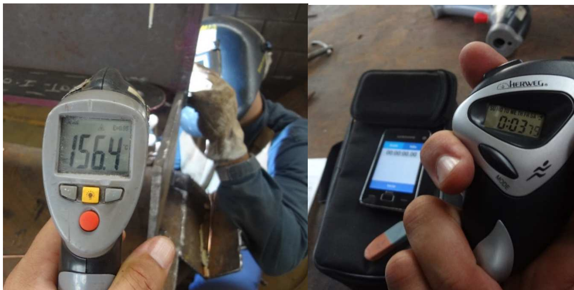
Figura 32 - Termômetro digital infravermelho verificando a temperatura na face oposta da solda em execução e Cronômetro em verificação no experimento.
