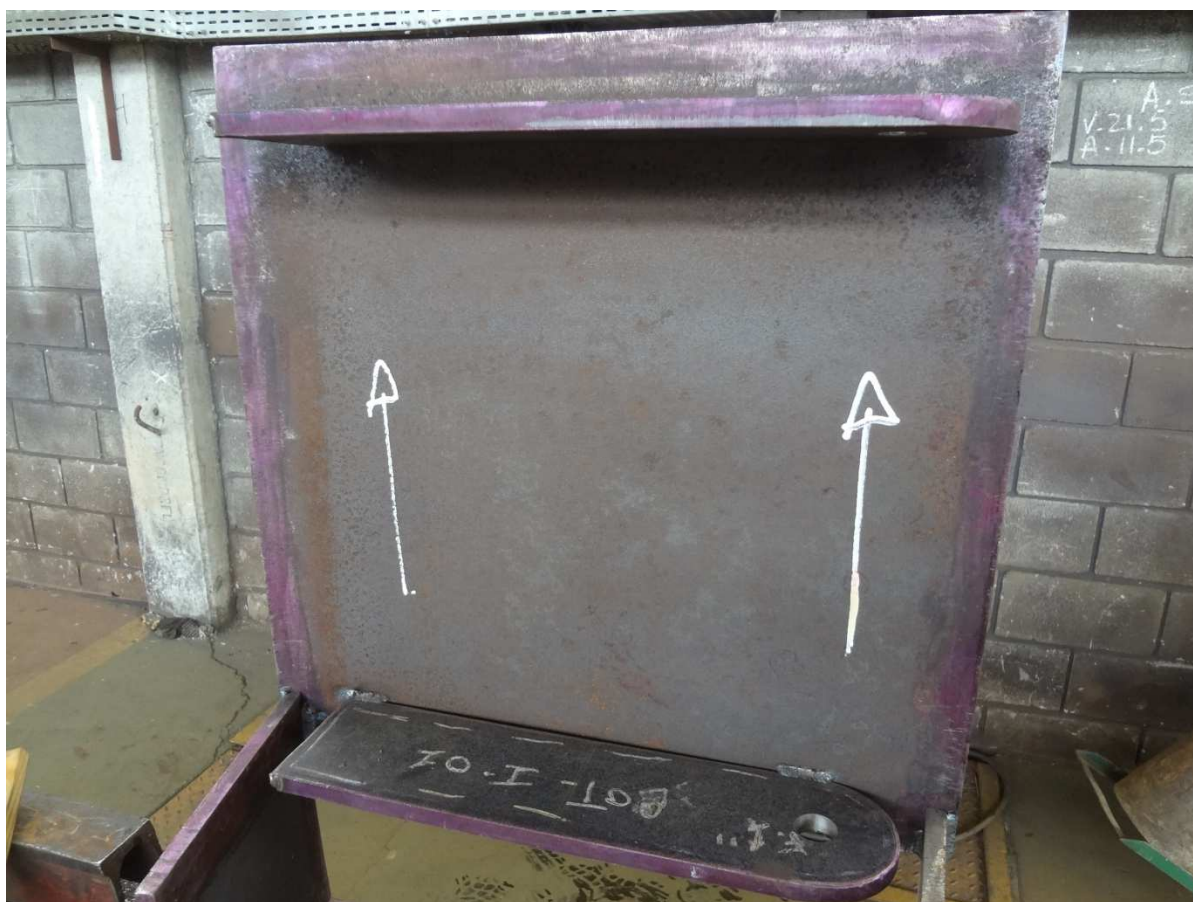
Figura 22 - Chapas de 9,53 mm soldadas travando a chapa de 25,4 mm.
