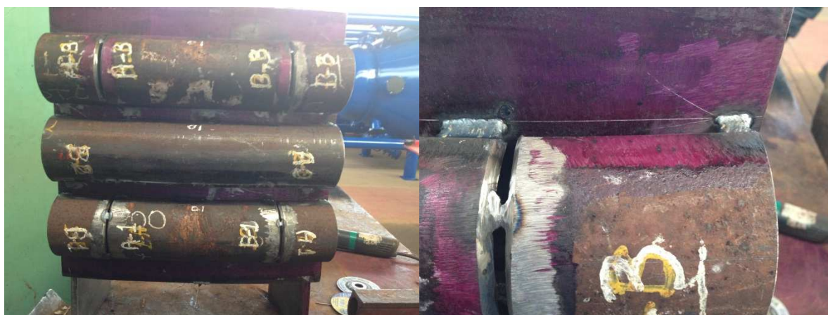
Figura 28 - Ponteamento e pré-montagem dos CP.
