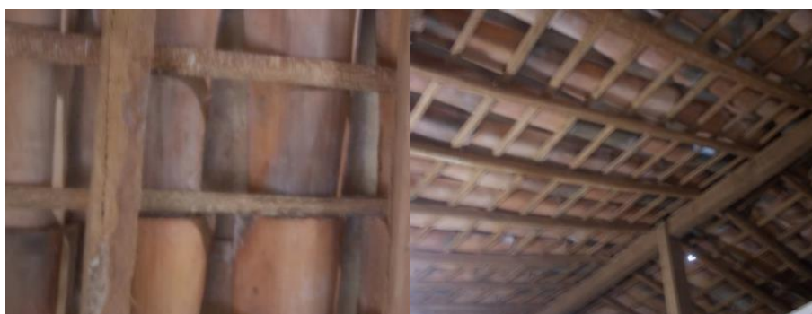
Figura 16 – a, b) Ripa e caibros de madeira de mandacaru - Caimbé-Euclides da Cunha-Bahia.
