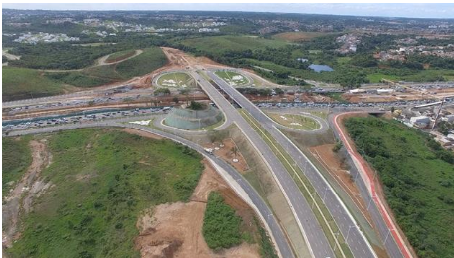
Figura 02 - Duplicação da Avenida Orlando Gomes – Viaduto da Avenida Paralela
