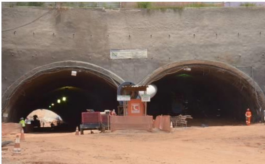
Figura 04 – Túneis da Ligação da Avenida Pinto de Aguiar com a Avenida Gal Costa
