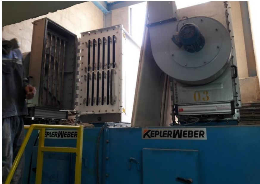
Ilustração 10 – Instalação dos Filtros na Linha TC-08
