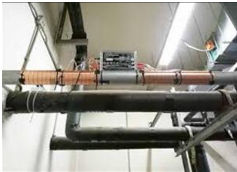
Figura 10: Vulcan instalado em tubulação de torre de resfriamento.
