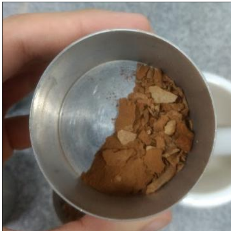
Figura 15: Amostra 02, entrada do trocador de calor.
