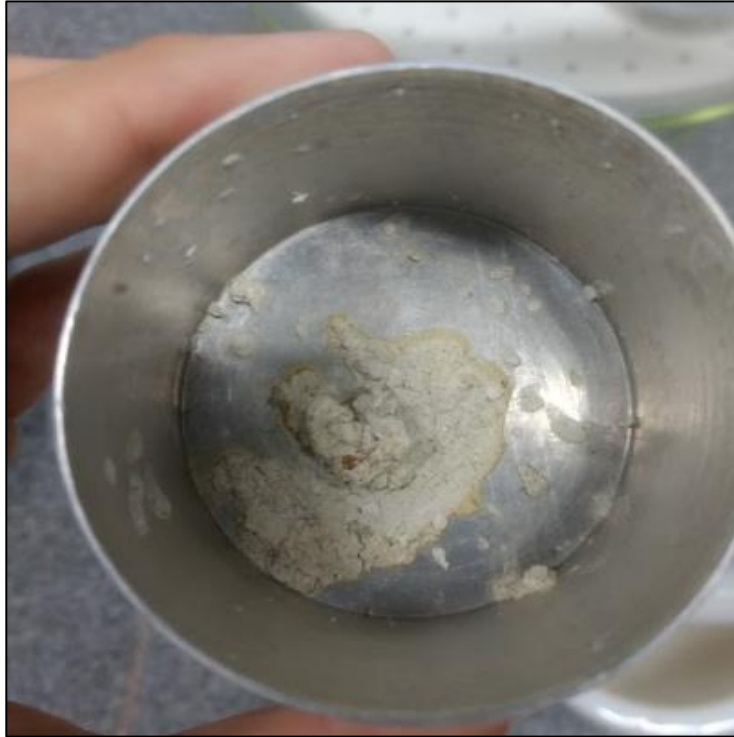
Figura 14: Amostra 01, bacia da torre de resfriamento.
