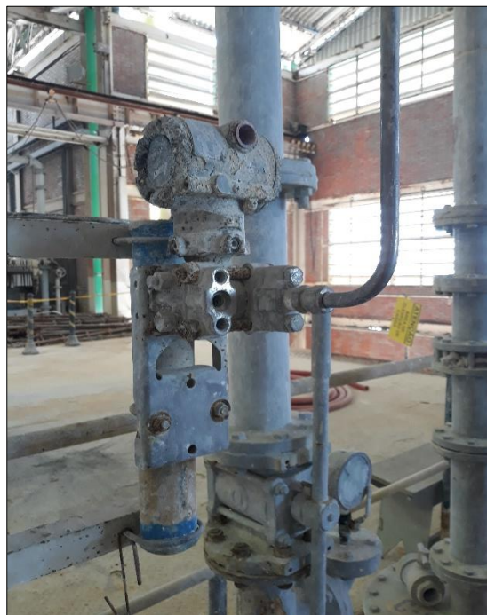
Figura 8: Transmissor de Pressão.
