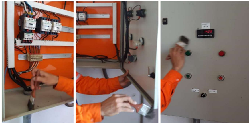
Figura 38 – Limpeza do Painel Elétrico.
