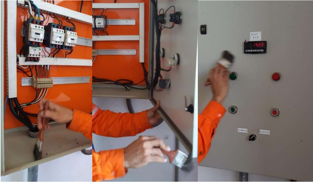
Figura 17 - Limpeza do Painel Elétrico.
