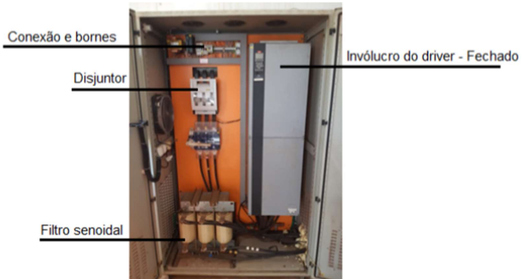
Figura 25 - Principais Componentes da Parte Dianteira do Inversor de Frequência.
