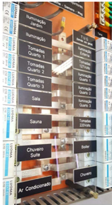
Figura 37 - Painel com Etiquetas Identificadoras.
