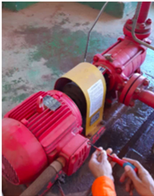
Figura 9 - Reaperto de Conexões do Motor.
