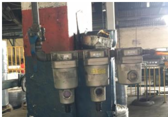
Figura 59: Sistema de filtragem de ar – Flexcoil.
