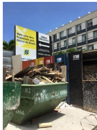
Figura 6: Segregação de resíduos em contêineres e armazenamento em baias
