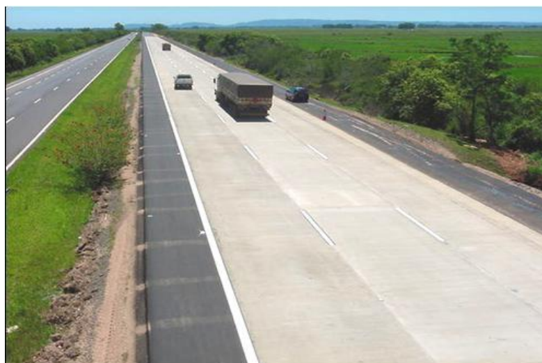
Figura 5: Diferença de reflexão de luz do concreto para o asfalto na BR-290, Rio Grande do Sul. Fonte: [11]
