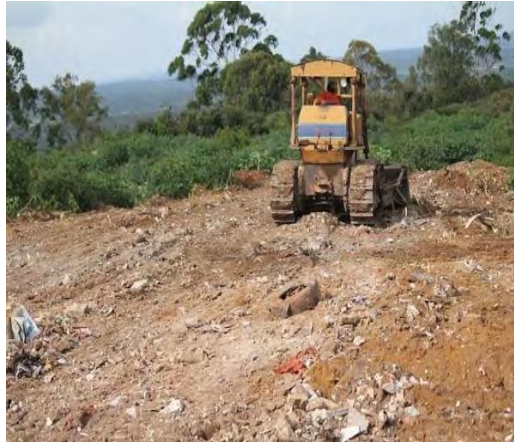
Figura 3 - Preenchimento de Solos Degradados com RCC. Fonte: Própria
