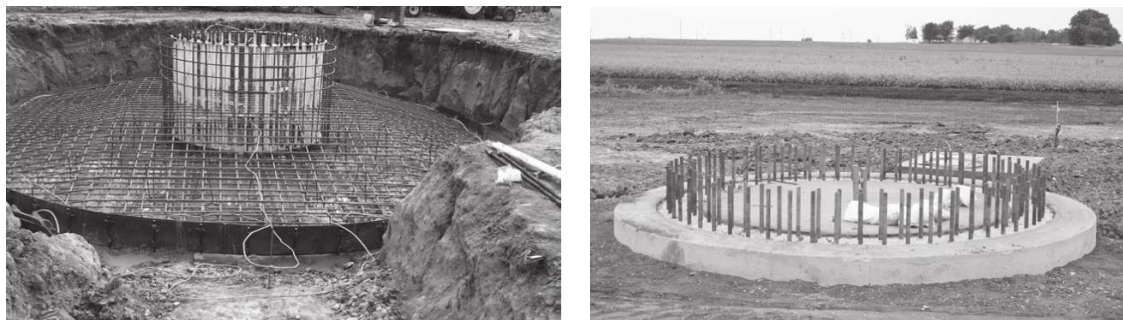
Figura 11: Fundação para a torre de uma turbina: (a) ferragem e (b) pós concretagem para montagem.
